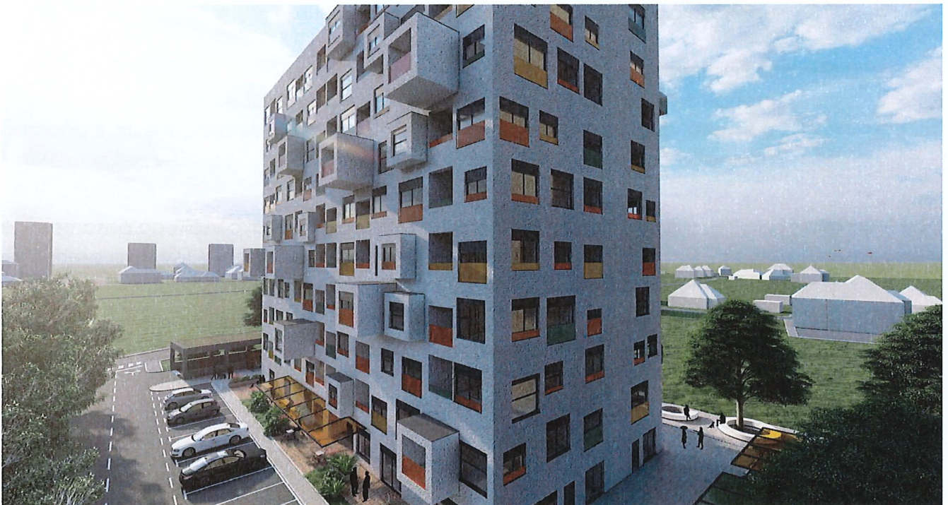
Stanovanjski projekt Ribarjeva rezidenca 3 (94 stanovanj v Celju)
