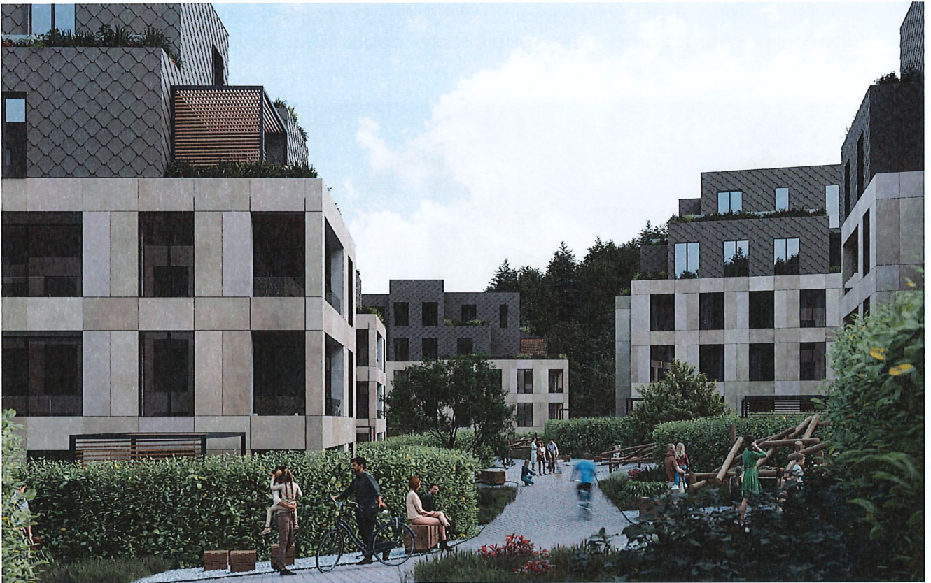
Stanovanjski projekt Pod hribom (100 stanovanj v Ljubljani)
