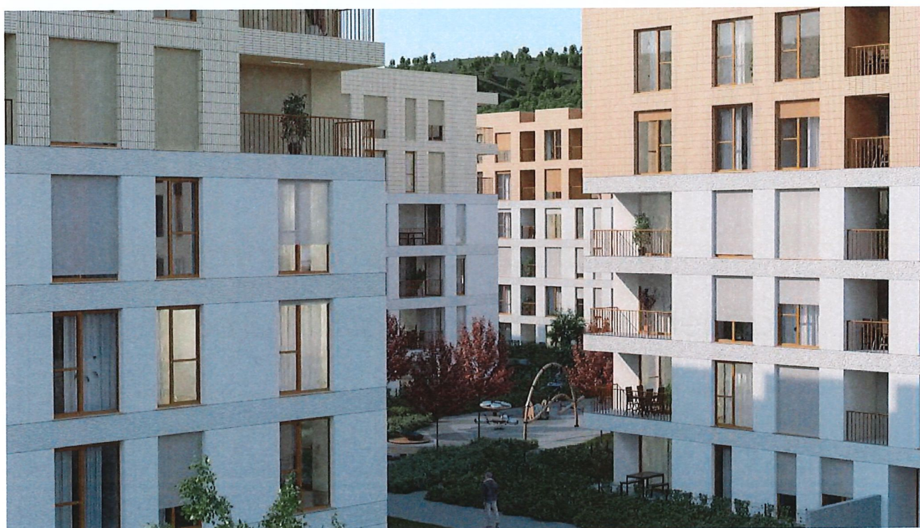
Poslovno-stanovanjski projekt Kranjska Iskrica (394 stanovanj in trgovina v Kranju)
